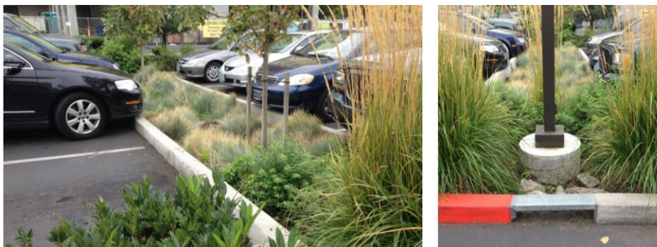
Figur 13. Exempel på växtbädd vid en parkering. Dagvattnet leds in i växtbädden via öppning i kantsten. Bild hämtat från Stockholm Vatten och Avfall.
