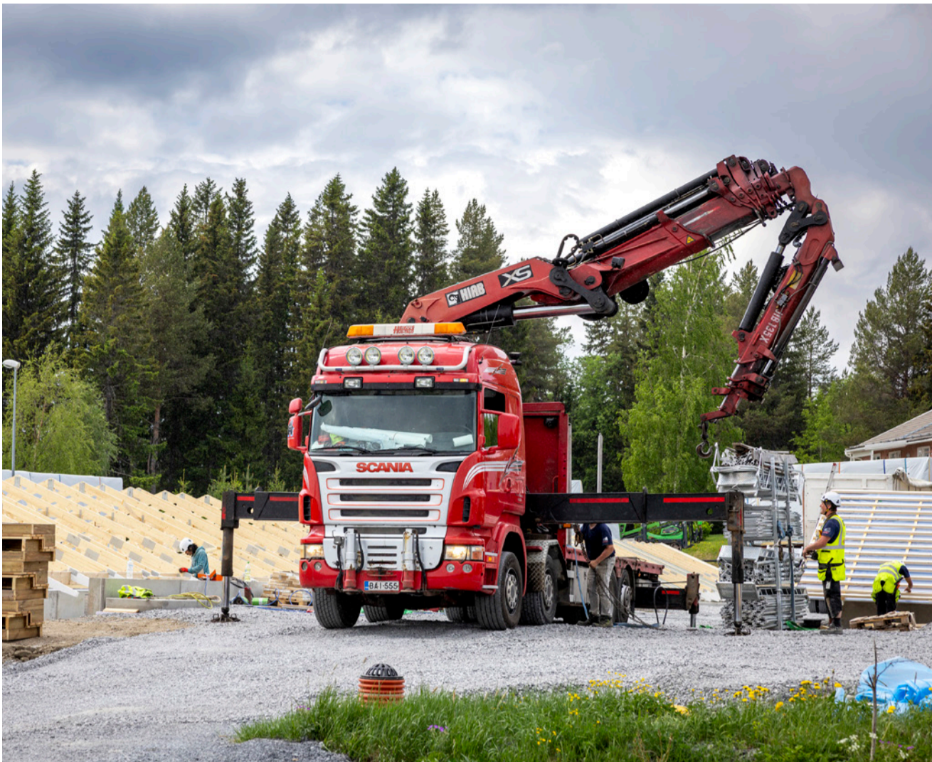
Tolv nya radhuslägenheter om 104 kvm med fem rum och kök i två plan samt uteplats med egen utgång byggs just på Ljungarvägen i Nälden. Inflyttning är planerad till oktober 2024.
