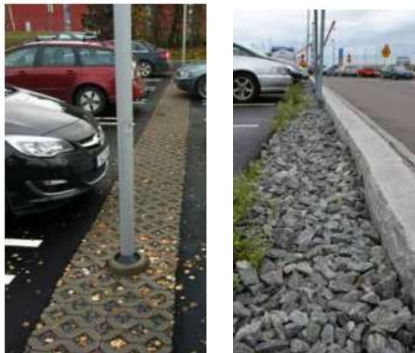
Bild 12. Till vänster en körbar yta med makadamdike under, till höger en ej körbar yta. Bild hämtad från Stockholm vatten och Avfall.
